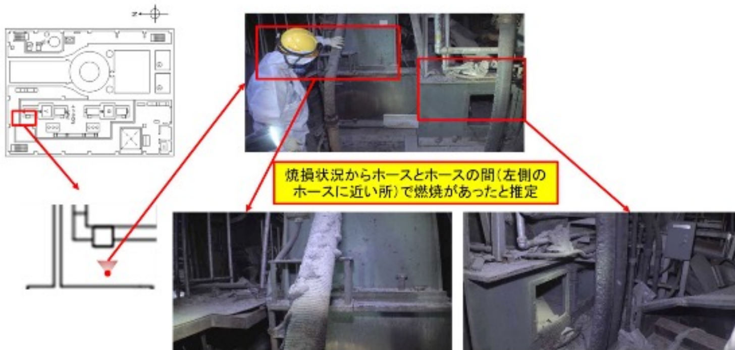
図10 MGセット(A)の西側(下部構造及びホース)の状況
