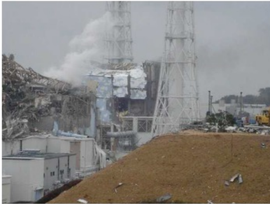
図3 2011年3月15日の4号機原子炉建屋の状況(その2) 8
