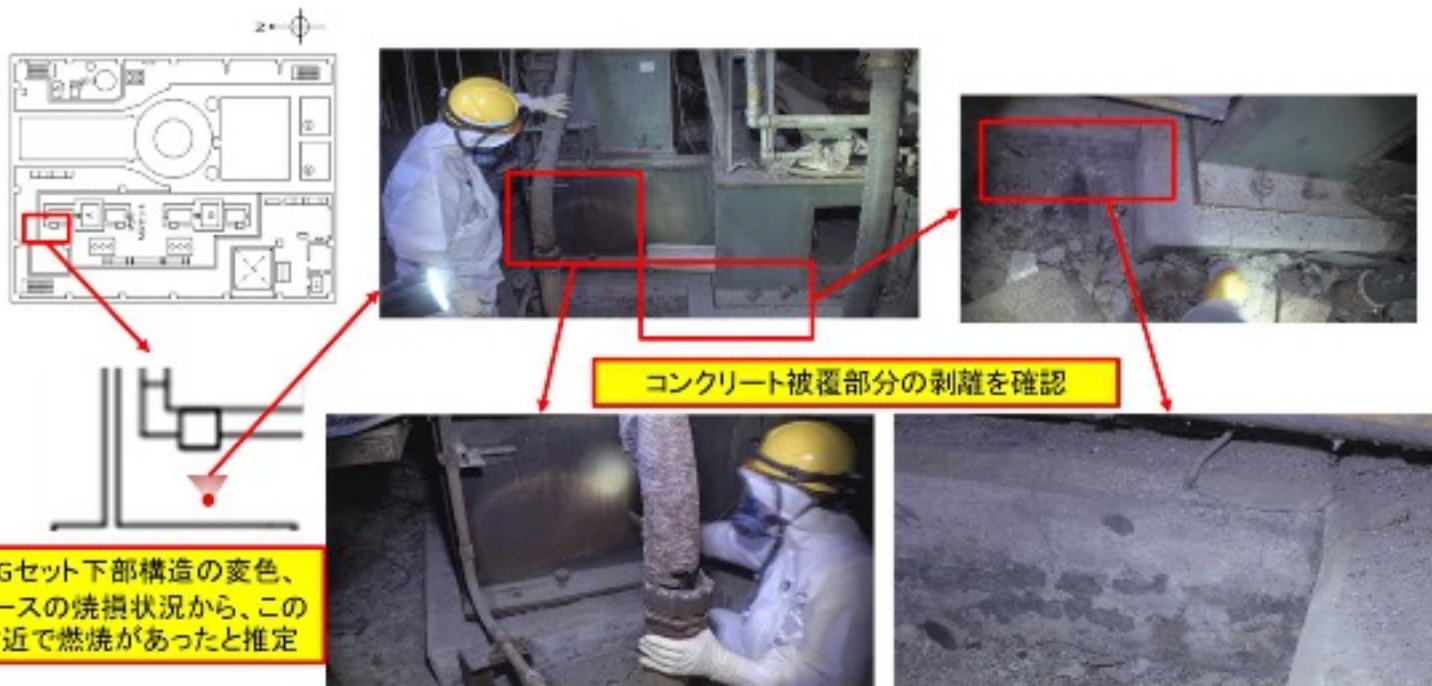
図 1 1 MG セット (A) の西側 (下部構造及びコンクリート基礎) の状況
